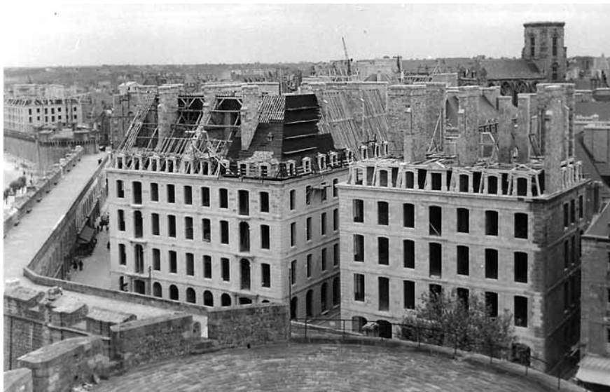
Figure 8 – Façades des anciens hôtels d’armateurs de l’entrée de la rue Saint-Vincent en cours de reconstruction « à l’identique » en 1950, Raymond Cornon, architecte en chef des Monuments historiques, la tour de la cathédrale avant la reconstruction de la flèche (cl. Dan Lailler, Musée de Saint-Malo)
