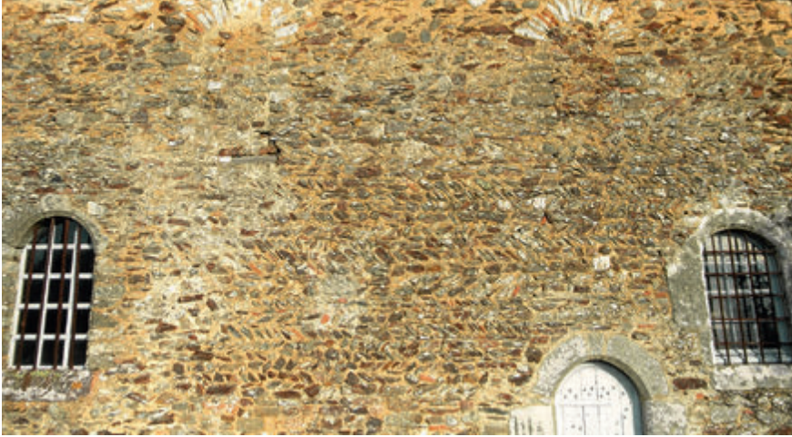
Figure 3 – Face sud de l'église (cl. P. Guigon, 9 février 2012)
