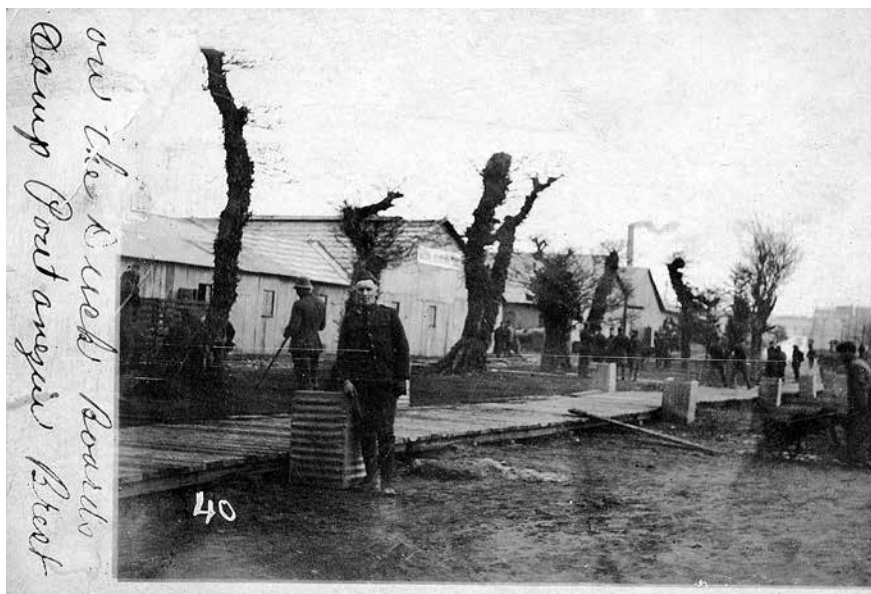
Figure 14 – Camp de Pontanezen-Caillebotis installé pour remédier à la boue du camp (Arch. mun. et communautaires de Brest, 2 Fi)
