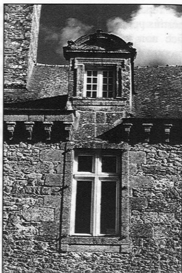
Saint-Brice-en-Coglès (Ille-et-Vilaine). Le Rocher-Portail. Détail d'une lucarne avec encadrement à crossettes.
