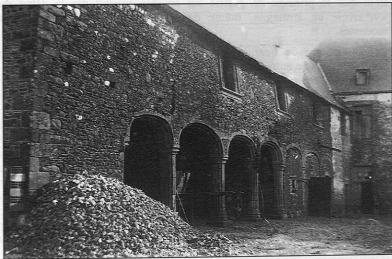
Plumieux (Côtes-d'Armor). Le Cambout. Détail de la galerie détruite. (Cl. Inv. Gén.).
