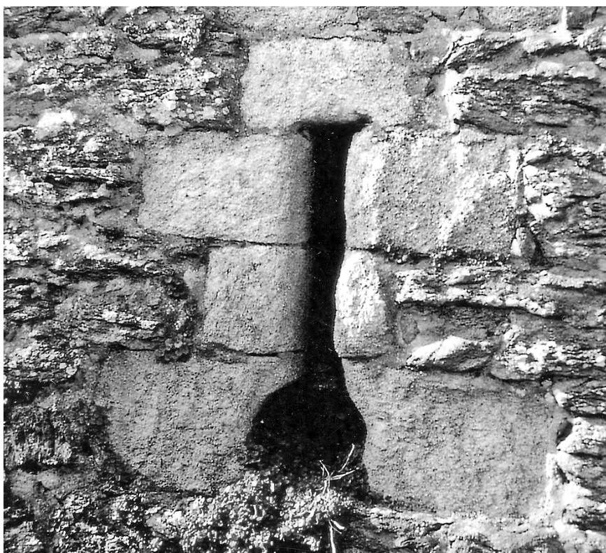
Figure 1 – Ravelin du château (xv e siècle), archère en granite de Trégana très érodé, moellons en gneiss de Brest
