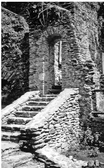
Figure 12 – Rue de Saint-Malo, gneiss de Brest en moellons
