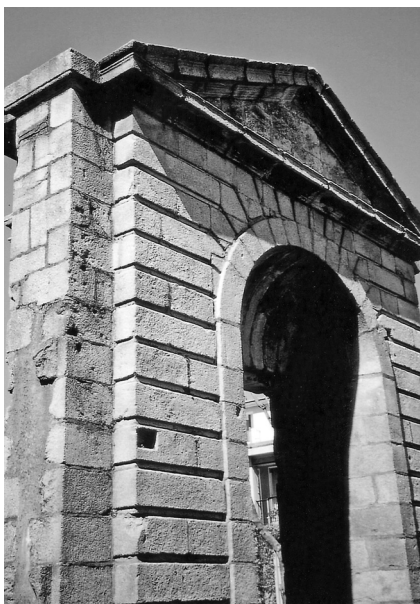
Figure 14 – Square L’Herminier, porte (remontée en 1951) de l’ancienne caserne Guépin, pierres de taille façonnées dans le faciès « Ségal » du massif de l’Aber-Ildut
