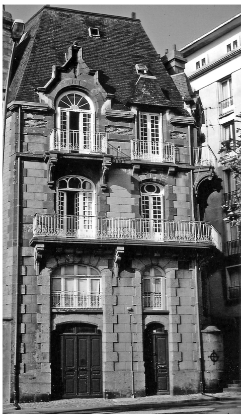
Figure 5 – Cours d’A jot (n° 20), immeuble (antérieur à la guerre) typiquement polyolithique, encadrements des ouvertures : au rez-de-chaussée et au premier étage en granite de l’Aber-Ildut ; aux deuxième et troisième étages, en kersanton ; microgranite de Logonna ; briques rouges
