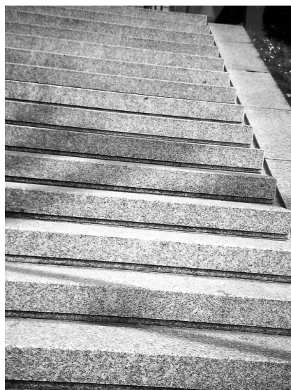
Figure 17 – Marches monolithes en granite du Tarn, à proximité de l'hôtel de ville
