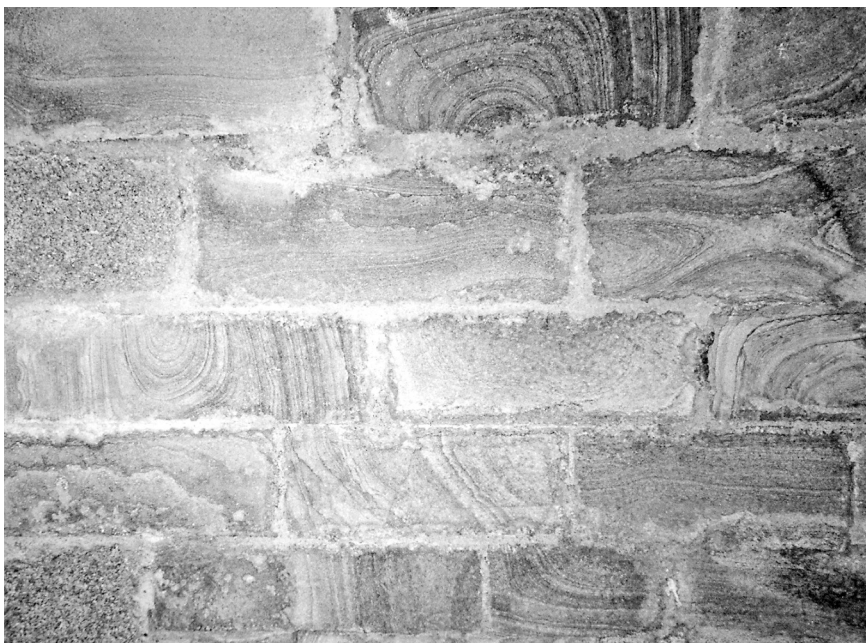
Figure 6 – Château de Brest. Salle voûtée sous l'ensemble du donjon, muraille en microgranite de Logonna aux nombreux cernes subconcentriques d'hydroxyde de fer ; à gauche, quelques éléments en granite de l'Aber-Ildut
