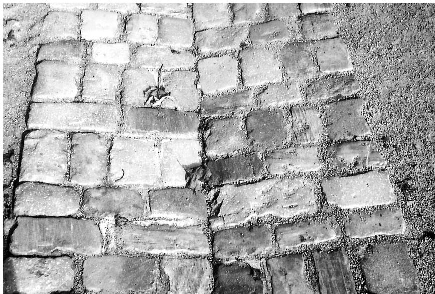
Figure 11 – Cours d'Ajot. Pavage d'un caniveau. Association aléatoire du grès d'Erquy et du microgranite de l'Île Longue
