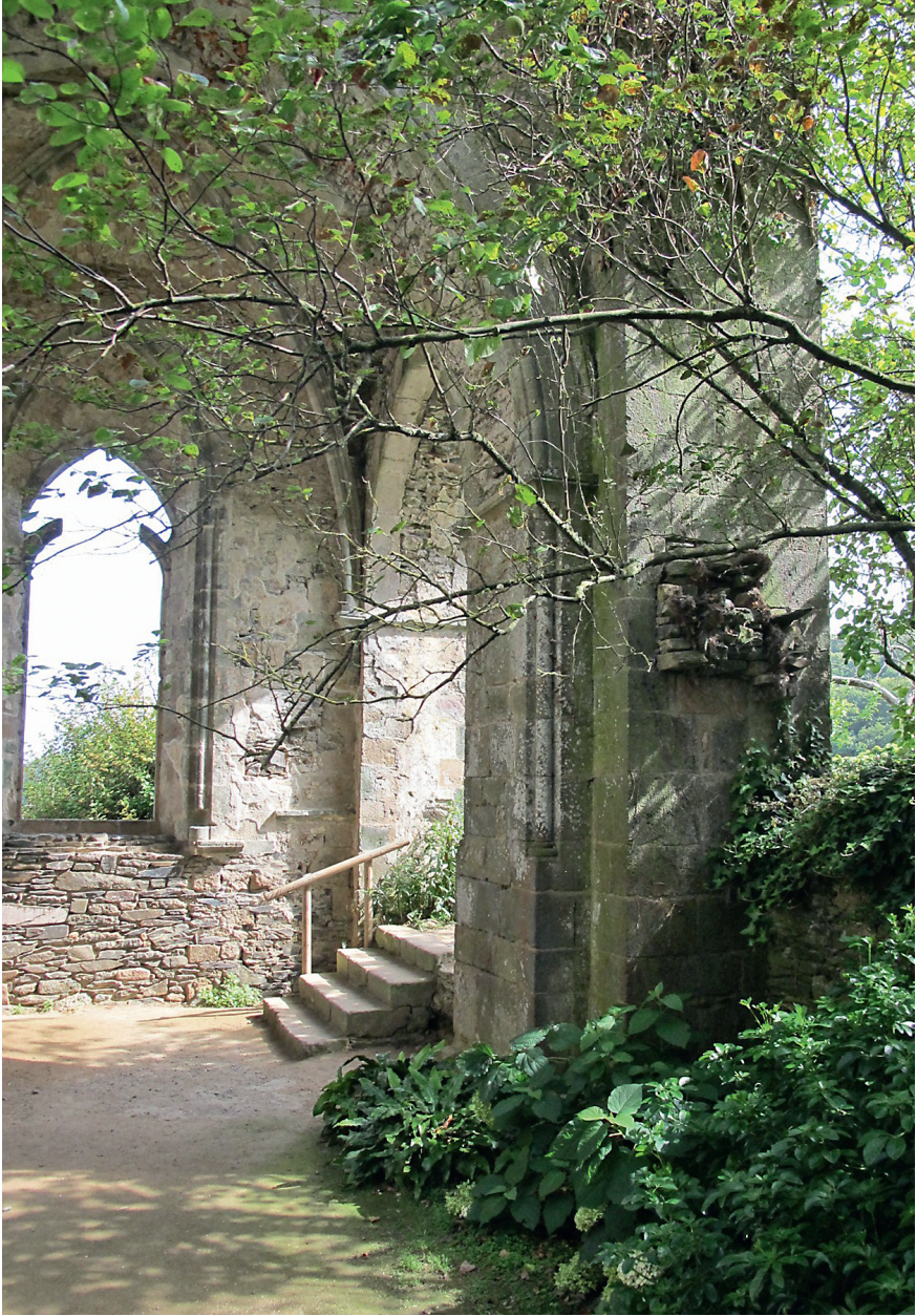
Figure 7 – Vue de la pile nord-est de la croisée et de la chapelle sud du bras nord. (cl. J.-J. Rioult, Région Bretagne)
