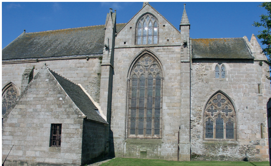
Figure 10 – Vue du chevet de l’église de la Roche-Derrien (cl. J.-J. Rioult, Région Bretagne)
