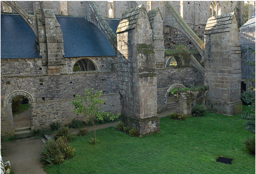
Figure 14 – Vue du côté nord de la nef montrant les deux séries d'arcs-boutants (cl. B. Bègne, Région Bretagne)
