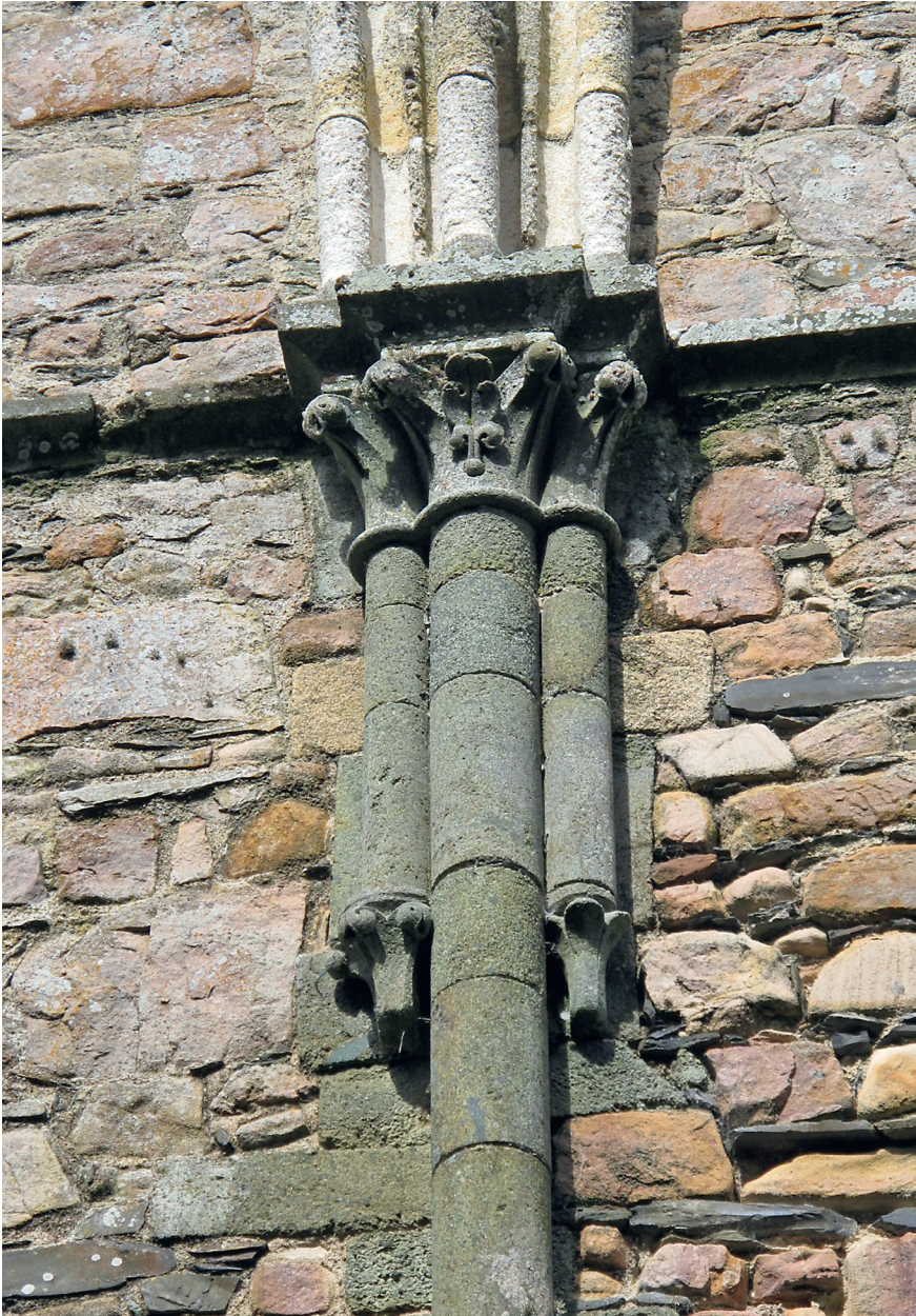
Figure 12 – Incrustation des colonnettes recevant les voûtes dans les murs de la nef (cl. B. Bègne, Région Bretagne)
