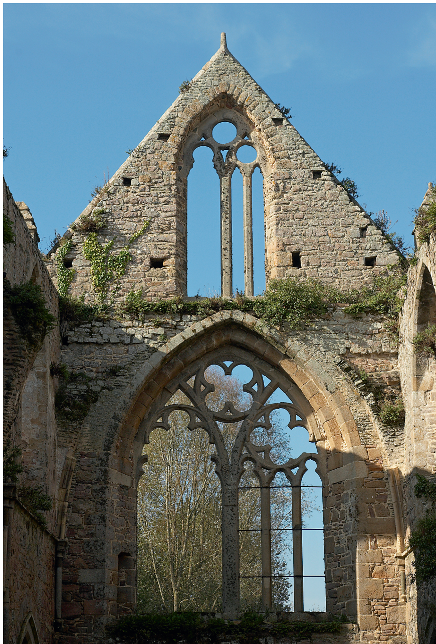
Figure 16 – Revers des baies de la façade occidentale (cl. B. Bègne, Région Bretagne)
