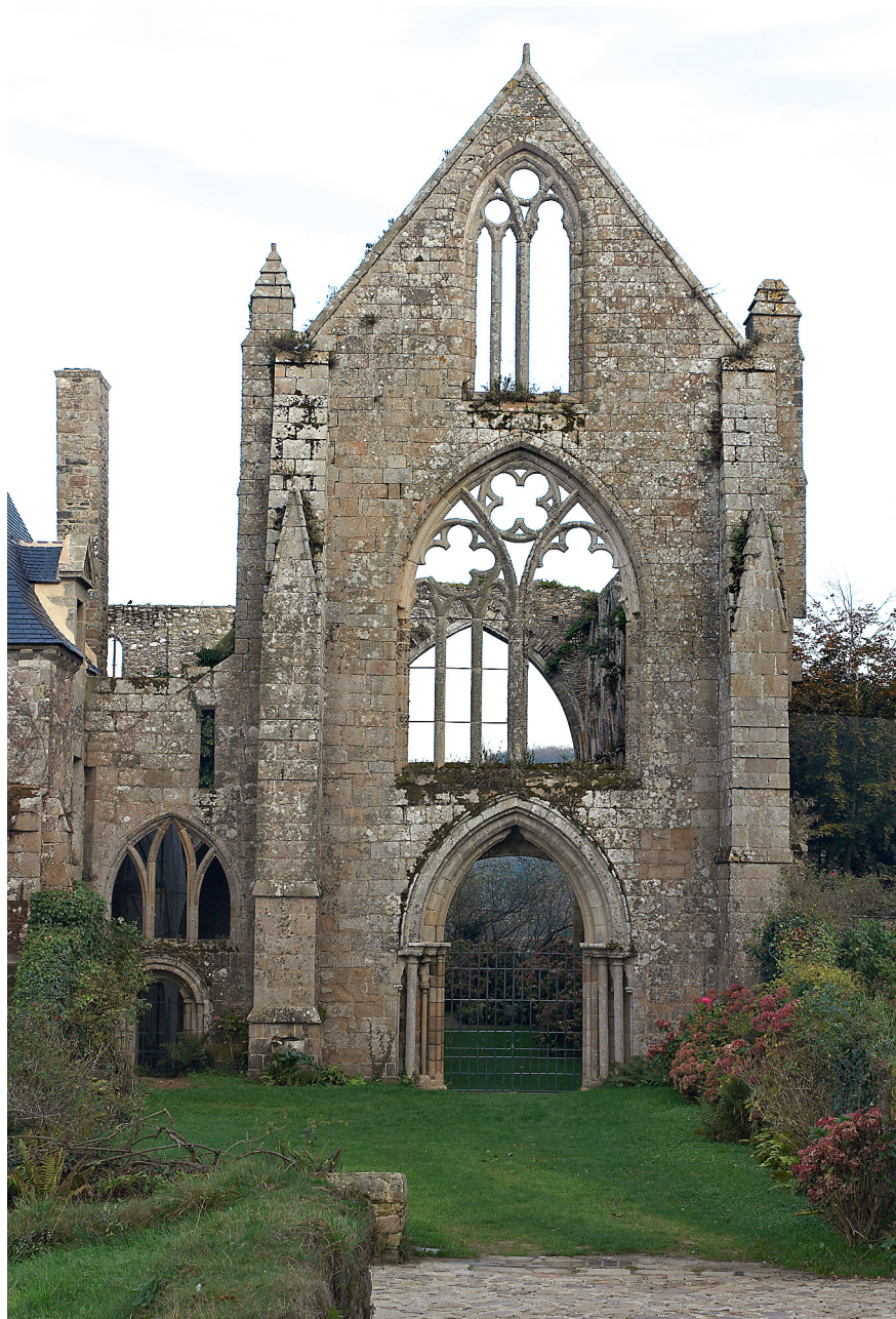
Figure 9 – Vue de la façade occidentale (cl. B. Bègne, Région Bretagne)
