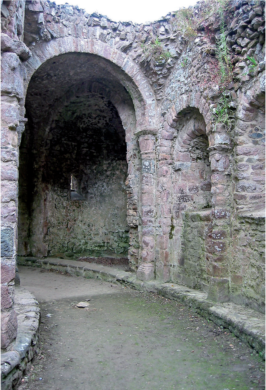
Figure 4 – Vue du collatéral prise vers la chapelle absidale sud (cl. G. Le Louarn-Plessix)
