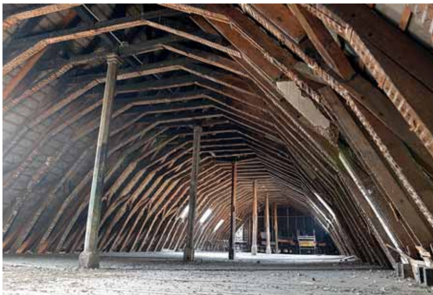
Figure 7 – Vue de la charpente du dortoir (cliché Patrick Jean, AMN)
