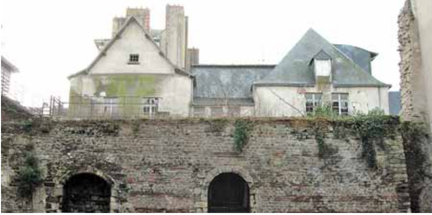
Figure 2 – Vue de la face nord de l’enceinte du Bas-Empire conservée dans la cour de l’école Saint-Pierre (d’après Ladiré, Damien, Couvent des Cordeliers, 5, rue du Refuge. Fouille préventive, étude documentaire et d’archéologie du bâti , rapport final d’opération, tome 2, fig. 6, pl. 3)
