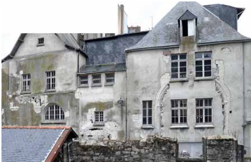
Figure 6 – Vue de la façade nord de la chapelle Compludo-Miranda avant sa démolition en 2011 (d'après Ladiré, Damien, Couvent des Cordeliers, 5, rue du Refuge. Fouille préventive, étude documentaire et d'archéologie du bâti , rapport final d'opération, tome 2, fig. 5, pl. 3)
