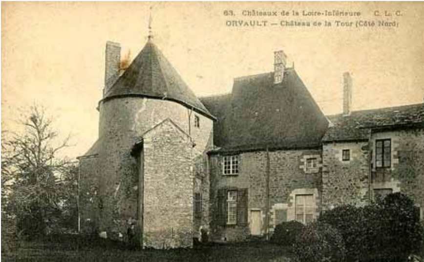
Figure 4 – La façade nord du château avant restauration (carte postale, vers 1904, coll. part.)
