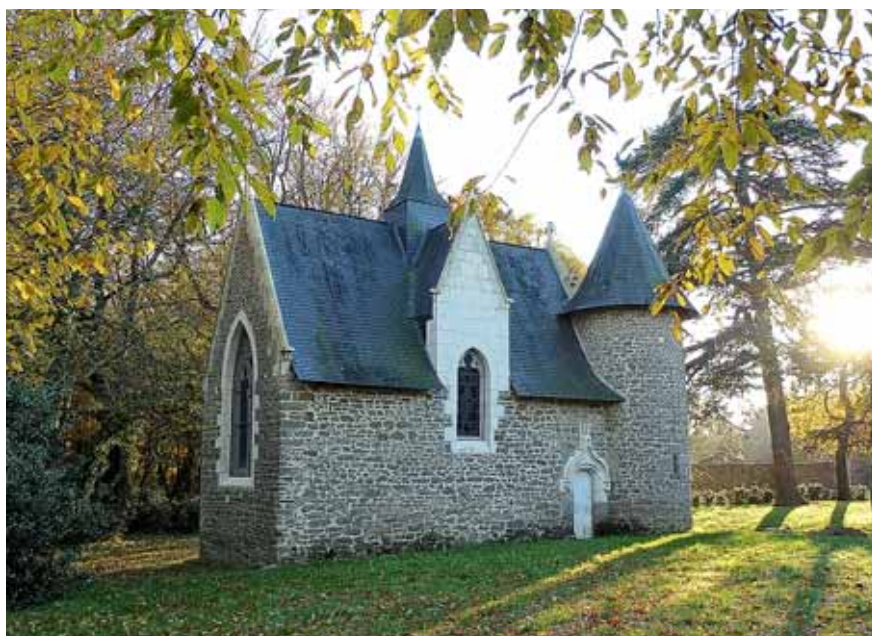
Figure 14 – La chapelle, avant et après restauration (cl. J.-F. Caraës)
