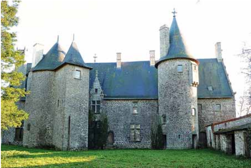
Figure 11 – La façade nord après restauration (état actuel) (cl. J.-F. Caraës)
