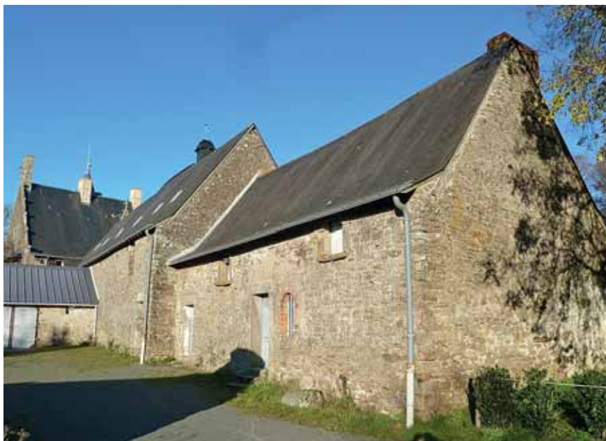
Figure 12 – Les communs, façade sur cour et façade ouest (état actuel) (cl. J.-F. Caraës)
