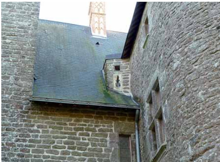
Figure 6 – Détail de la façade nord (état actuel) (cl. J.-F. Caraës)
