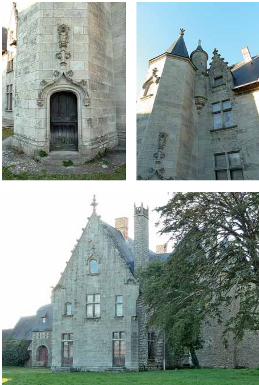
Figure 10 – Détails de la façade sud et pignon est (état actuel) (cl. J.-F. Caraës)
