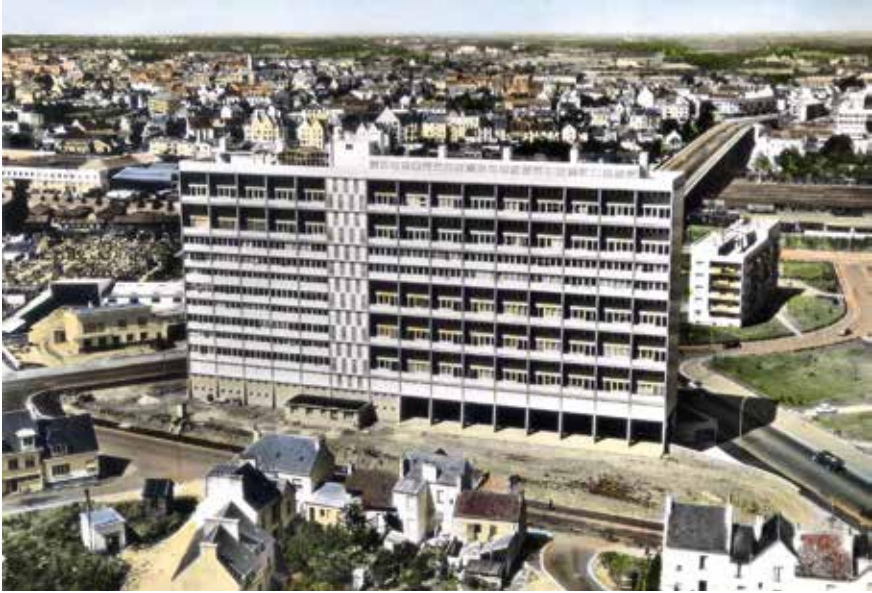
Figure 4 – L'immeuble du Moustoir, Henri Conan architecte, 1963-1964 (coll. part)
