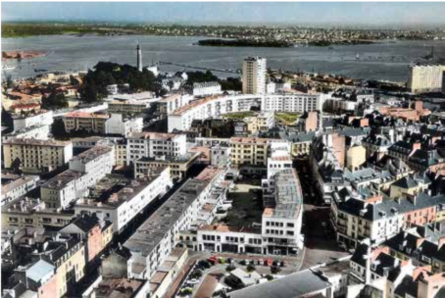
Figure 5 – Le centre-ville en fin de reconstruction, le système d'îlots avec dans le fond l'ensemble de la Banane avec sa tour de quatorze étages devant l'Hôtel Gabriel qui vient d'être restauré, 1963-1964 (coll. part)
