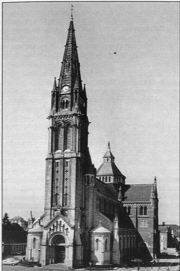
Figure 8. – Janzé, église Saint-Martin, vue du sud-ouest (cl. Inv. Artur/Lambart).
