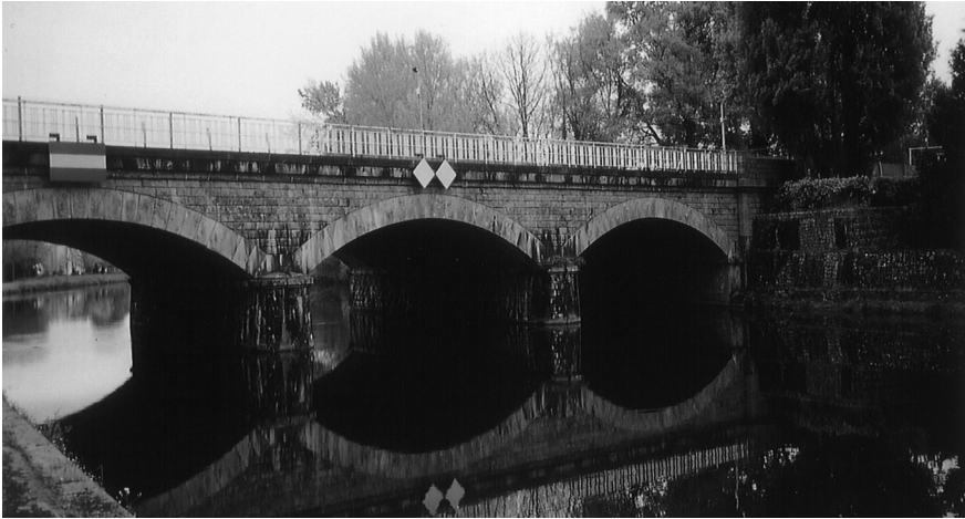
Figure 12 – À Pontivy, pont sur le Blavet pour la voie ferrée en direction d'Auray ; mise en œuvre du granite local (cl. L. Chauris)
