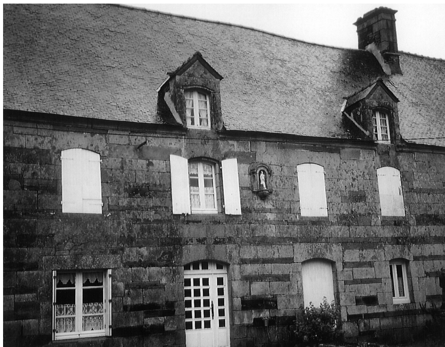
Figure 6 – À Bodion en Pluméliau, assises alternées schiste briovérien-granite (cl. L. Chauris)
