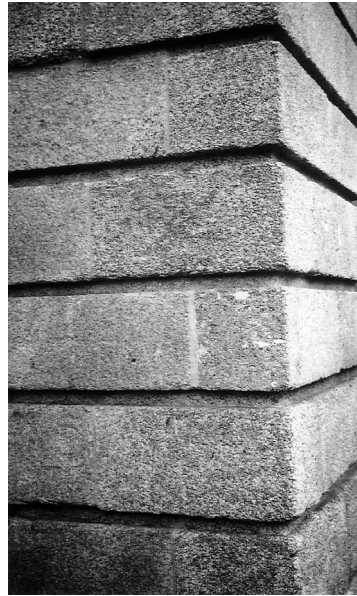
Figure 13 – Halle-théâtre à Pontivy, appareillage très soigné du granite local (cl. L. Chauris)
