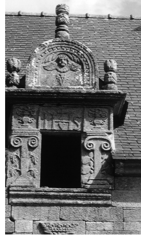
Figure 8 – À Colmario en Cléguérec, remarquable aptitude du schiste bleu pâle au façonnement élaboré (cl. L. Chauris)
