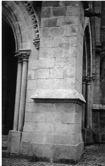
Figure 10 – Vue partielle du clocher-porche de l'église Saint-Joseph à Pontivy, en bel appareil façonné dans le granite à gros grain (cl. L. Chauris)
