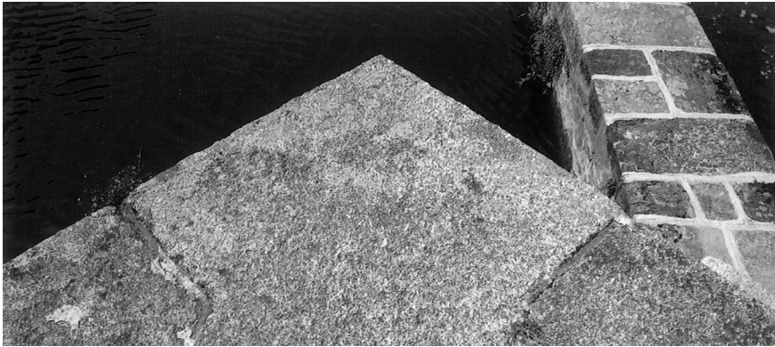
Figure 11 – Écluse de Roc'h Moten sur le Blavet canalisé, Appareillage très soigné du musoir en granite de Pontivy (cl. L. Chauris)
