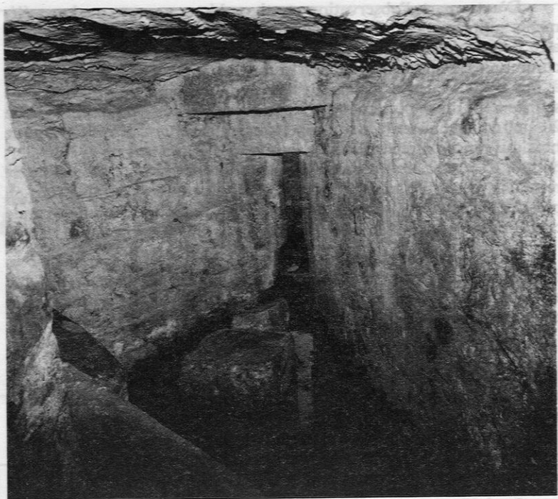
Archère canonnière de la tour nord
