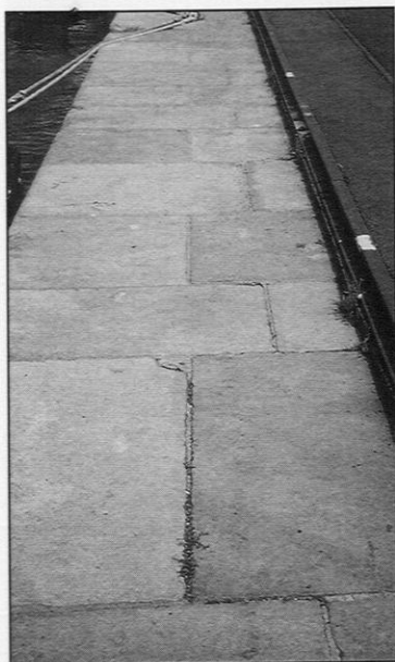
Bassin de Saint-Nazaire. Tablette du quai en granite de Lavau avec ses deux nuances de teinte.
