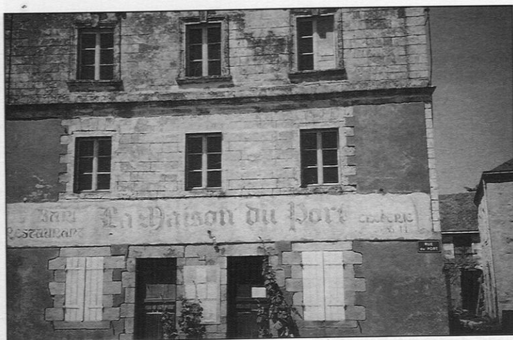
«Maison du port» à Lavau. Rez-de-chaussée en granite. Etages en tuffeau.
