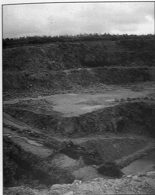
Figure 1 - Vue partielle de la profonde carrière de Kerlin, à l'ouest de Sarzeau, exploitant les migmatites (recoupées par des filons granitiques), pour granulats et enrochements.
