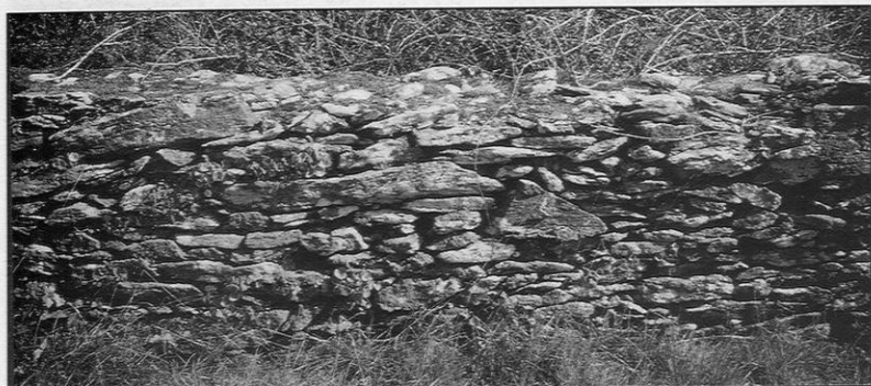
Figure 8 – Moellons hétérométriques de micaschistes, dans une murette en pierres sèches près de la Pierre Jaune.
