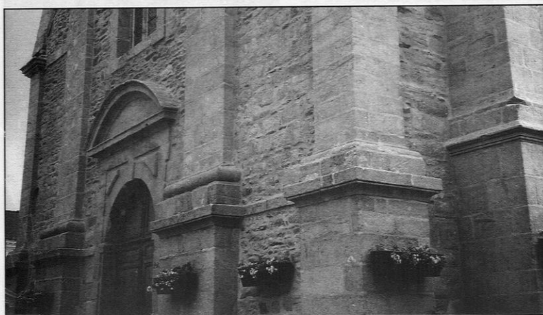
Figure 15 – Façade principale de l'église de Sarzeau. Contreforts en granite fin gris à ocre.
