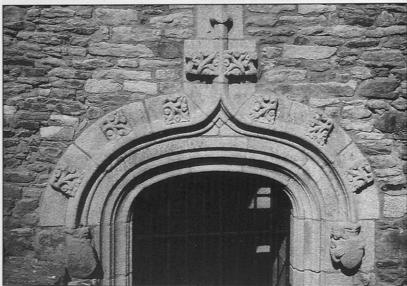
Figure 18 – Château de Suscinio. Logis ouest. Porte restaurée, en leucogranite, à grain moyen, du Morbihan intérieur.
