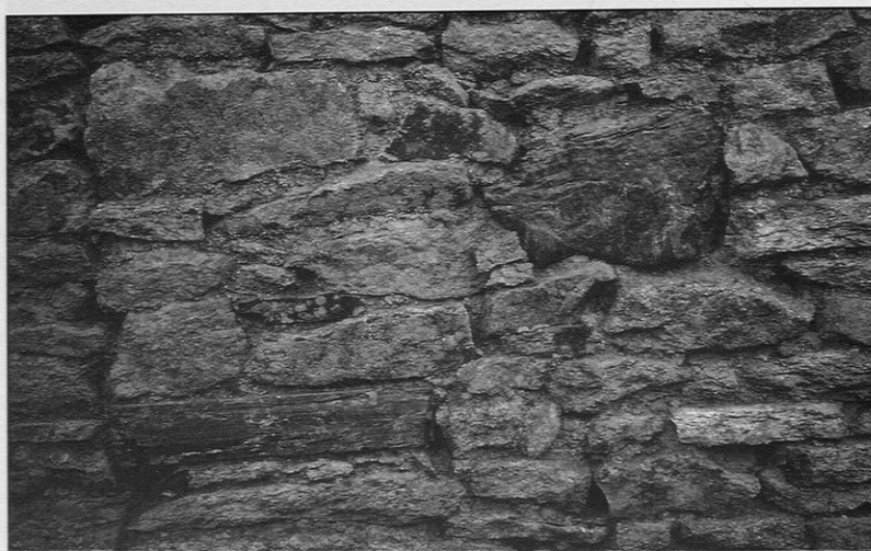
Figure 10 – Manoir de Kerguet. Deux moellons en phtanite bleu-noir, au sein de l'élévation en granite cataclastique.
