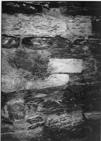
Remparts. Avancée triangulaire. Juxtaposition aléatoire de grès et de schistes en moellons allongés.
