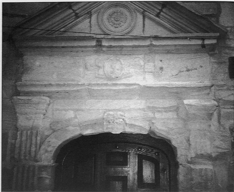
Rue de La Baudrairie, n° 16, porte Renaissance en grès.
