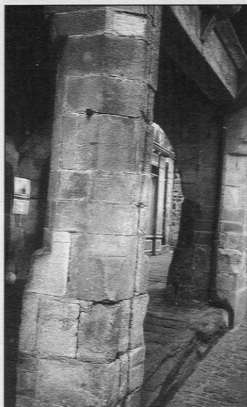
Rue de La Poterie. Pilier extérieur en grès d'une demeure à colombage.
