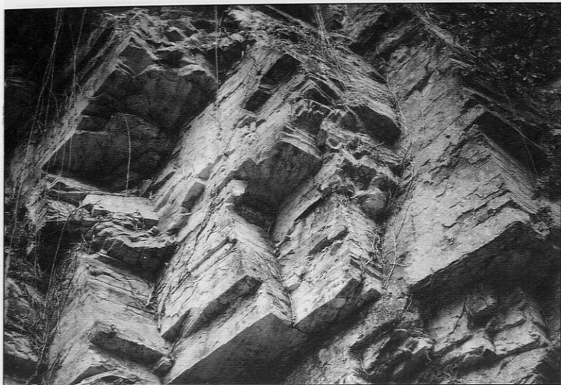
Ancienne carrière de grès de Vitré au Bas-Pont. Vue partielle d'un front de taille offrant un dispositif en bancs réguliers.
