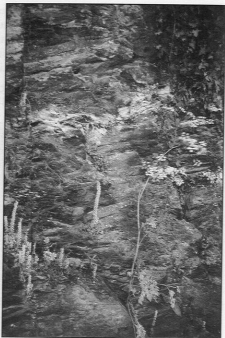
Escarpement de schiste bleu sombre, rue du Val.
