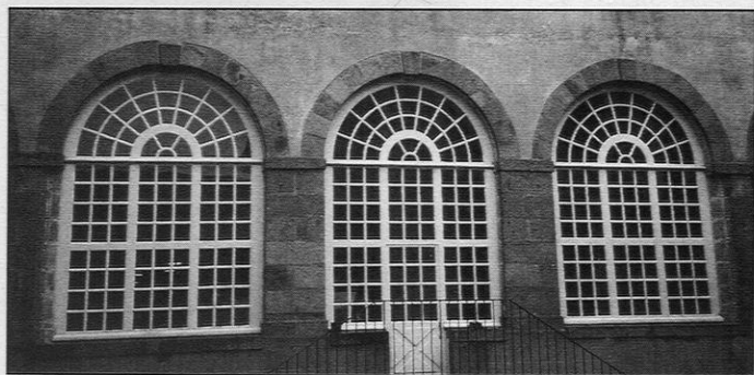
Monastère Saint-Nicolas. Baies en grès de Vitré.
