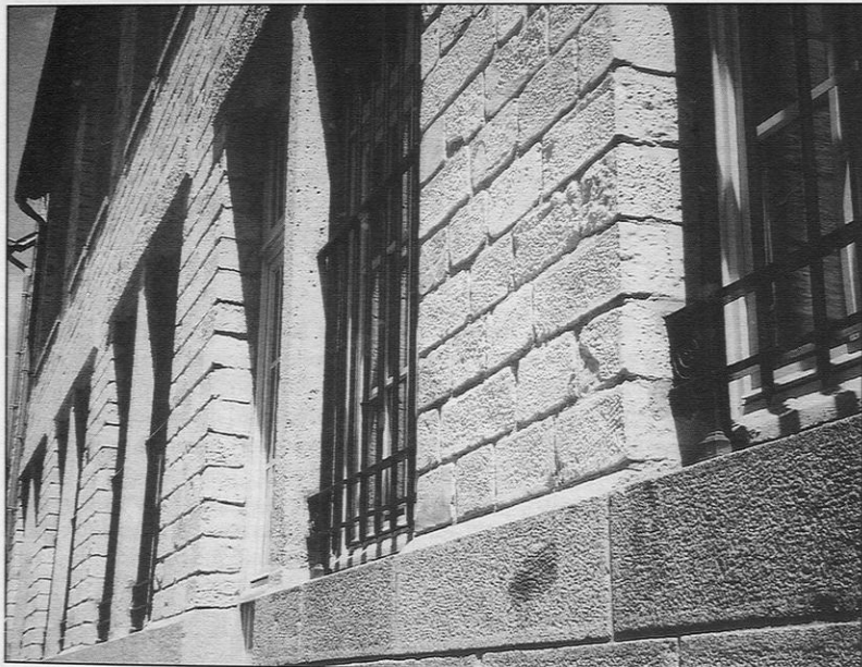
Poste de Vitré. Soubassement en granite mancellien. Élévation en grès local régulièrement assisé.
