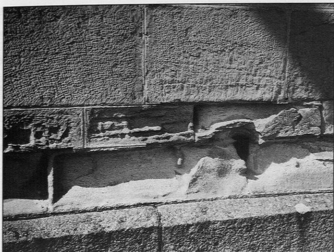
Église Saint-Martin. Élévation méridionale. Sur un soubassement en granite du batholite mancellien, deux assises en grès de Vitré profondément érodé et devenant pulvérulent. Au-dessus, le grès présente encore les traces du bouchardage.
