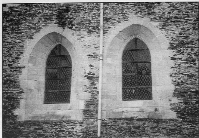
Couvent des Augustins. Contraste entre les pierres de taille en grès clair des baies et les petits moellons schisteux de l'élévation.
