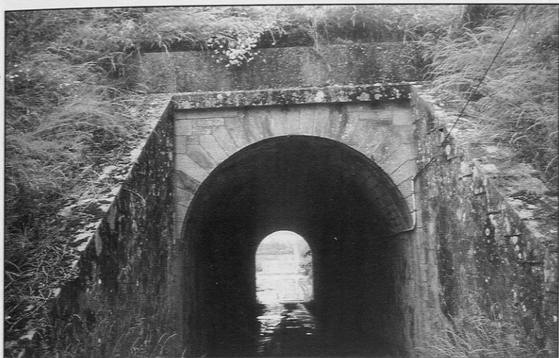
Pont sous la voie ferrée Paris-Brest, un peu à l'Ouest de Vitré. Pierres de taille en granite mancellien, moellons en grès de Vitré.
