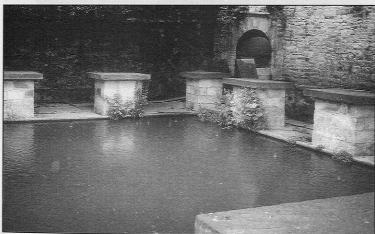
Vue partielle du lavoir dans le monastère Saint-Nicolas. Tables à laver monolithes en schiste bleu sur un soubassement en grès.
