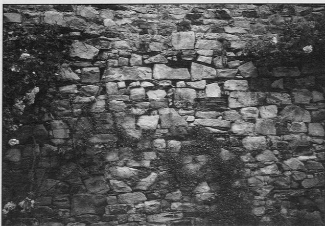
Vue très partielle du mur de clôture de l'ancien couvent des Augustines. En ce point, les moellons gréseux, de façonnement irrégulier, dominent largement sur les moellons schisteux.
