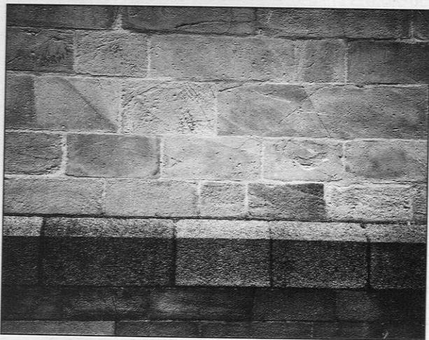
Élévation méridionale de Notre-Dame. Bandeau chanfreiné en granite (du Perdre ?), surmonté par le grès de Vitré en beaux moellons, régulièrement assisés, localement desquamés.
