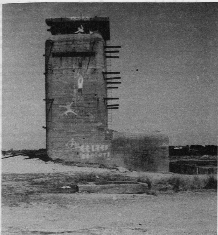
Plouharnel. Poste d'observation et de direction de tir à plusieurs étapes.
