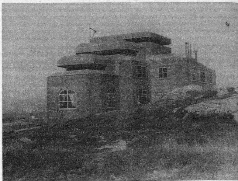
La Dilanne. Poste de direction de tir en 1945.
