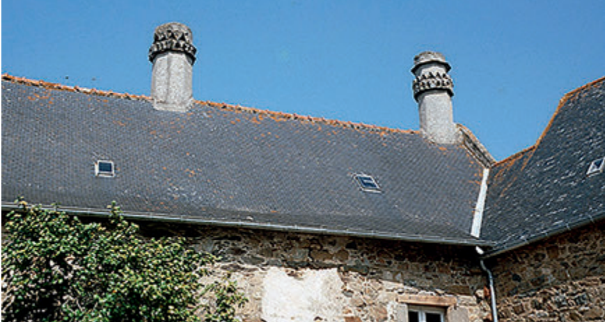
Figure 8 – Le Carpont : deux souches de cheminées octogonales marquent l'extrémité haute, seigneuriale, de la maison (Arch. dép. Ile-et-Vilaine, fonds Meirion-Jones, 40 Fi 13580, le 27 août 1984)
