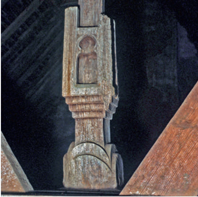
Figure 12 – Le Carpont, la charpente d'origine du xiv e siècle : élément du poinçon (Arch. dép. Ille-et-Vilaine, fonds Meirion-Jones, 40 Fi 04770, le 29 juillet 1985)
