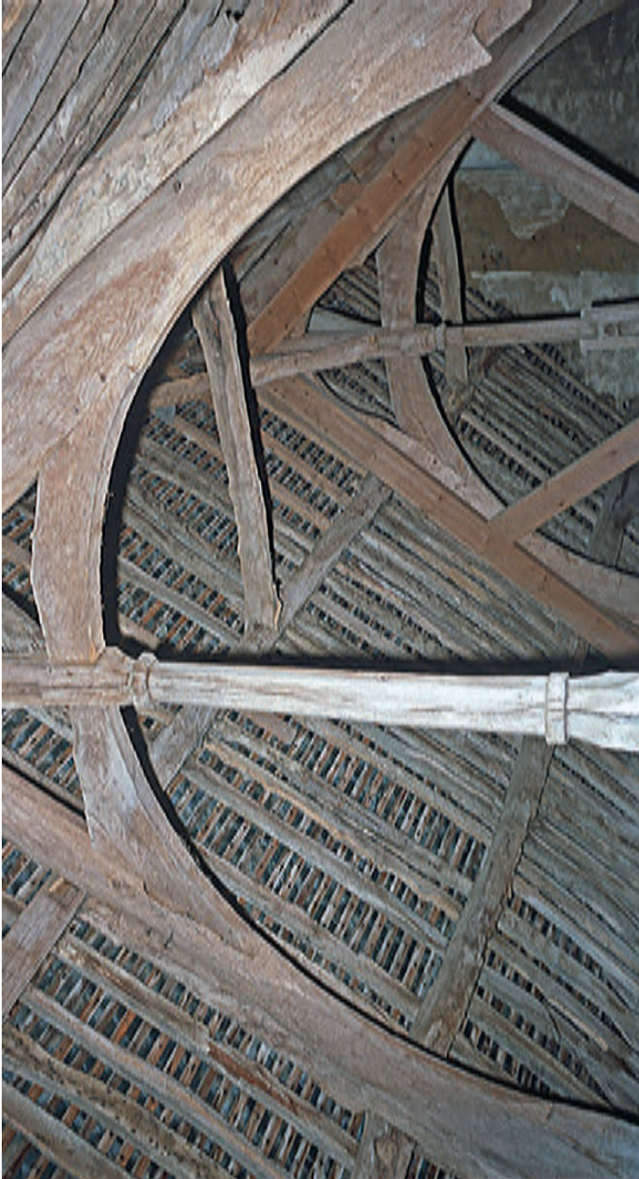
Figure 11 – Le Carpont, la charpente d'origine du xiv^e siècle, au-dessus de la salle basse actuelle (Arch. dép. Ille-et-Vilaine, fonds Meirion-Jones, 40 Fi 13598, le 29 juillet 1985)
