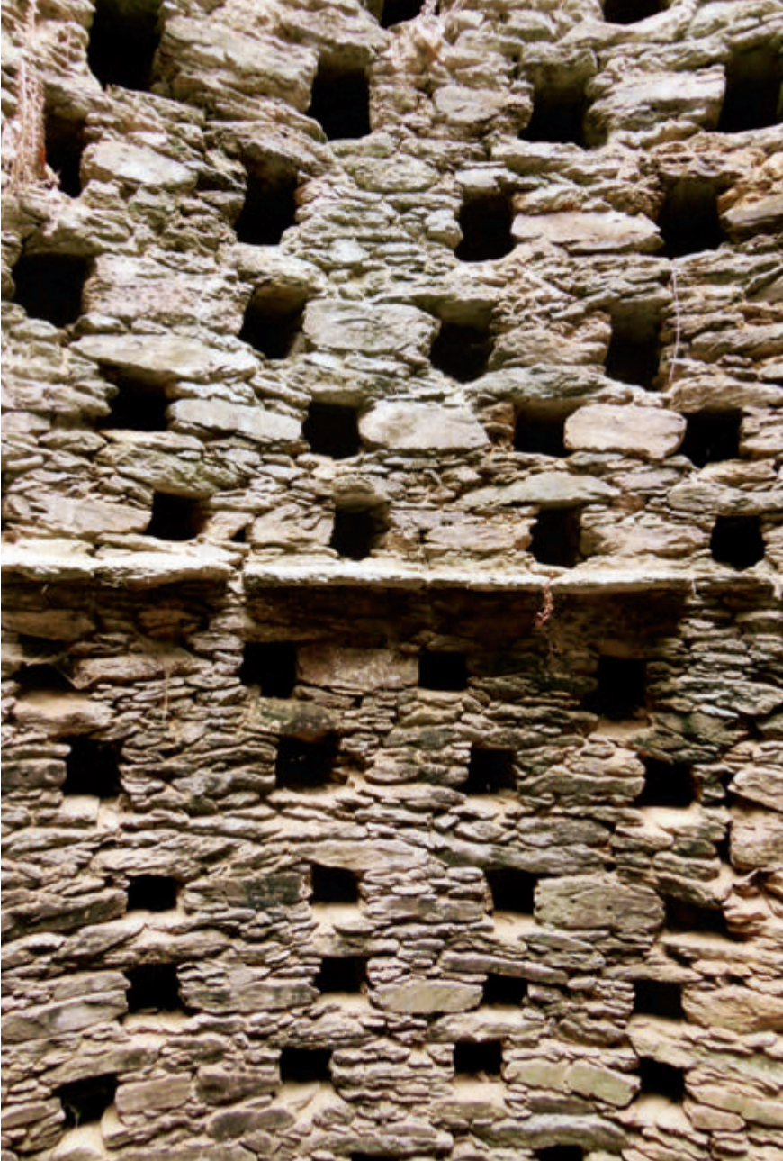
Photo 1 – Minihy-Tréguier, boulins dans le colombier de la chapellenie (cl. Louis Chauris)
