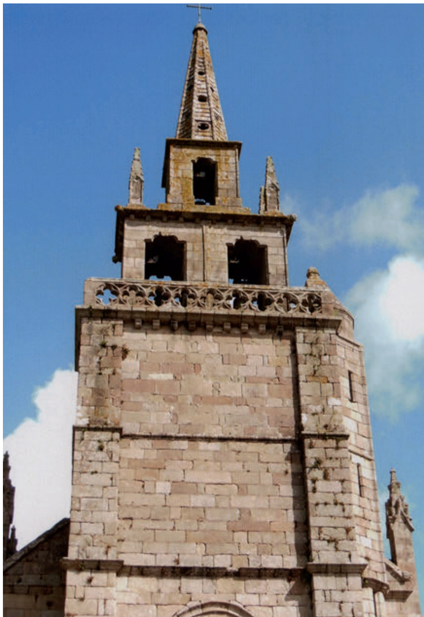
Photo 6 – Minihy-Tréguier, l'église, façade occidentale, mise en œuvre des trois faciès granitiques de l'Île-Grande (cl. L. Chauris)
