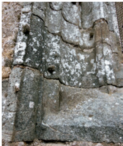
Photo 4 – Minihy-Tréguier, l'église, partie inférieure, en « tuffeau vert » d'une baie méridionale (cl. L. Chauris)
