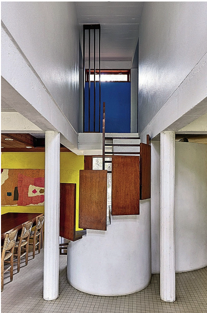
Figure 4 – Saint-Brevin-les-Pins, villa Chupin, l'escalier conçu à l'origine sans garde-corps (© Christophe Dugied)
