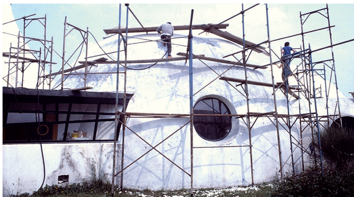
Figures 11-13 – MOUETTE, Henri SZÉKELY, Pierre et Vera, Chantier de la coupole principale du village Renouveau de Ty Nod, 1968 (cl. Les Villages clubs du soleil)
